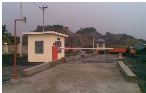
H. 1 Hệ thống trạm cân ô tô điện tử ứng dụng thẻ RFID
